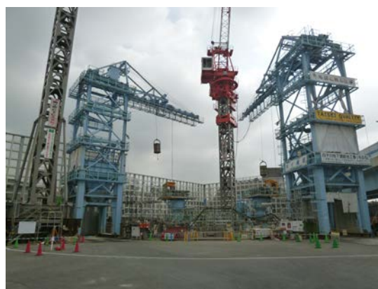
写真-4 到達立坑全景
