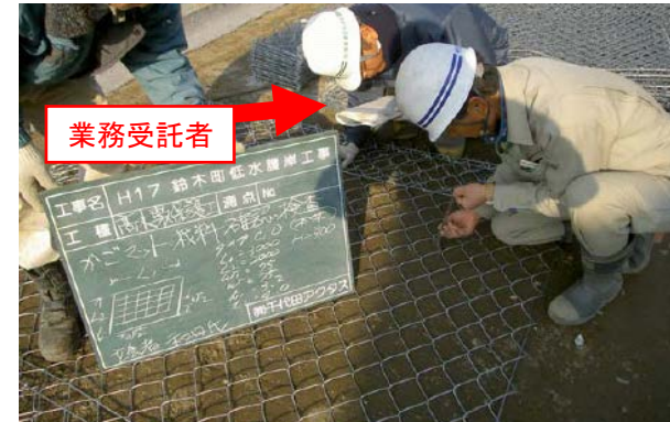
(河川護岸用かごマットの材料確認)
