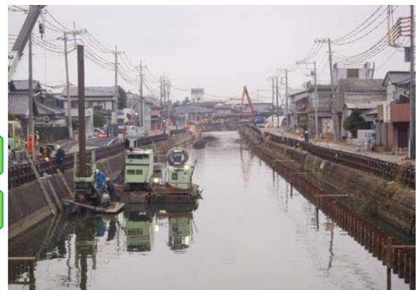
地震時に、小野川周辺の液状化に伴い、地盤が水平方向に側方流動したことで、河床が約2m隆起し河道閉塞が起きました。また、右岸368m、左岸337mの護岸は兩岸の土地が住宅とともに河川方向に2m程度移動した影響で、押し出されて崩壊し、川幅は最大約4m狭くなっています。
