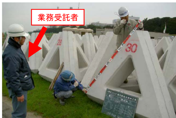
(根固めブロックの材料確認)
