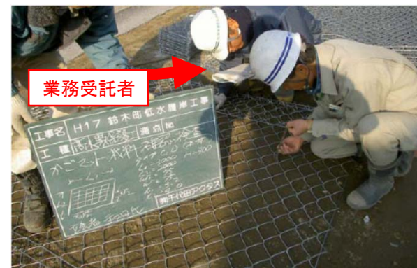
(河川護岸用かごマットの材料確認)
