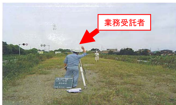
(現場状況の照合を実施)
