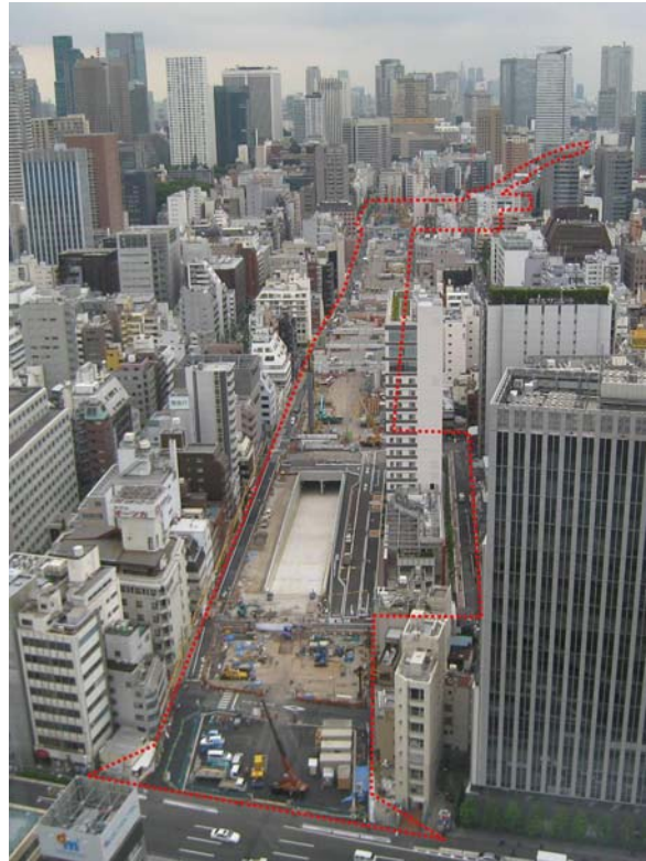
(図3 用地買収状況[新橋側より])
