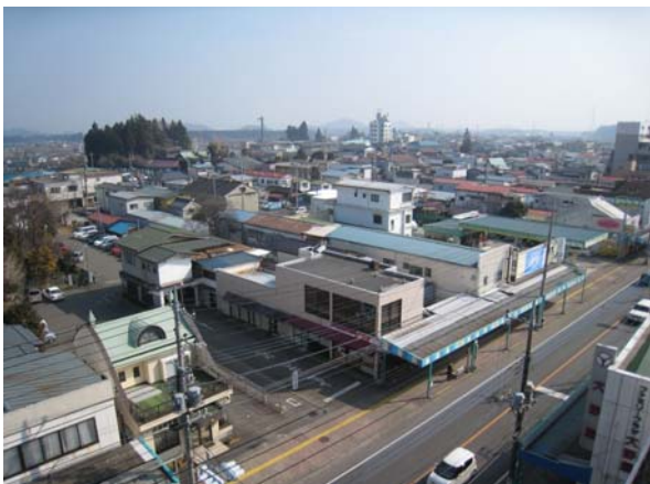
《小倉町周辺整備事業予定箇所》
