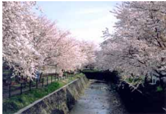
排水立坑付近
