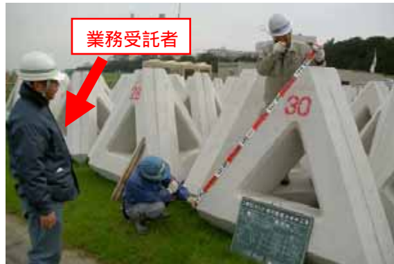
(根固めブロックの材料確認)
