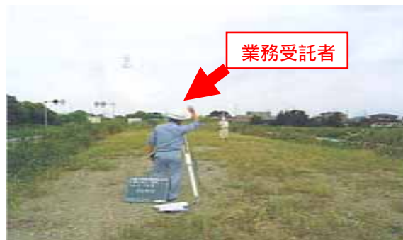
(現場状況の照合を実施)
