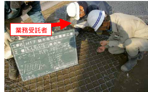
(河川護岸用かごマットの材料確認)
