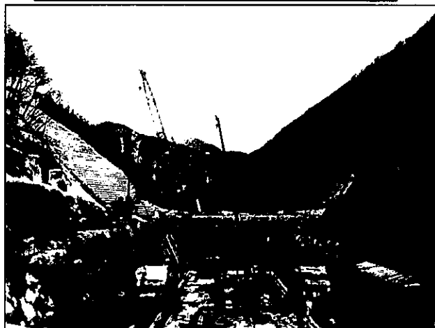
ダム本体工事状況
