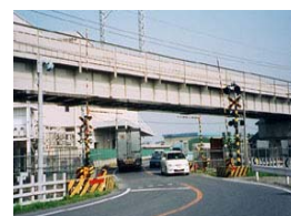
踏切除去前の様子
