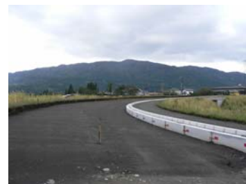
(主) 中之条湯河原線 須川バイパス (平成16年度供用予定)
