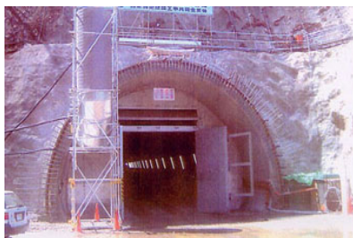
(一) 林吾妻線バイパス(吾妻トンネル)
