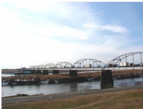
工事前の昭和橋
