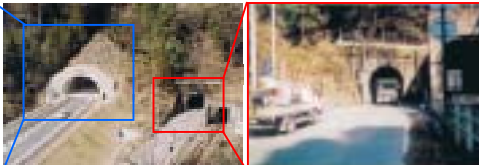
図：十方峡トンネル【資料：国土交通省】
