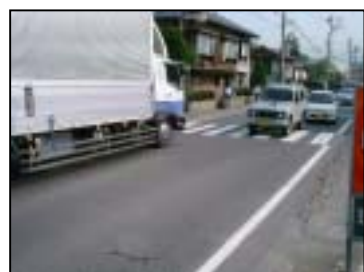
図：民家の直近を通過する大型車（国道152号丸子町）【資料：長野県】
