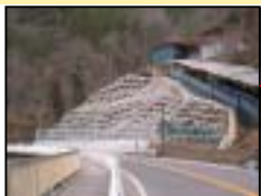
図：国道19号 雲根他防災工事（生坂村）【資料：国土交通省】
