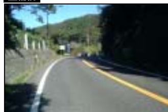
写真：国道19号におけるセンターポールの設置
