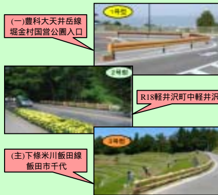
図：信州型木製ガードレール整備事例【資料：長野県】
