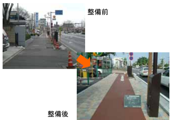
【整備事例(一)石倉前橋停車場線】
