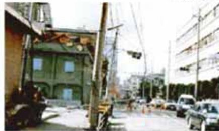
阪神大震災で倒壊した電柱
