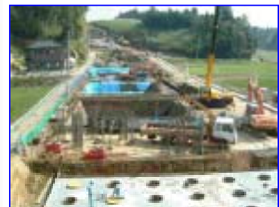
高架部工事の様子
