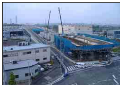
<国立高架橋の工事の状況>
