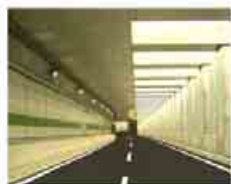
薩馬トンネル内部
