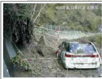
平成16年の台風による被害(1)
