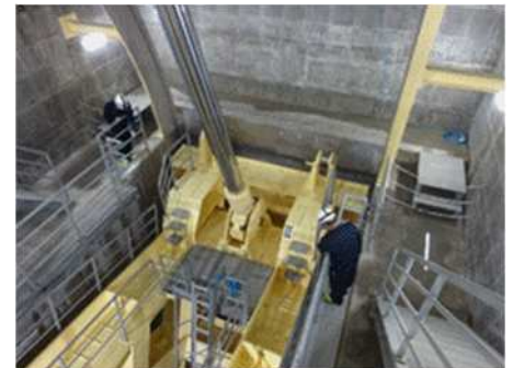
ゲート設備点検保守
