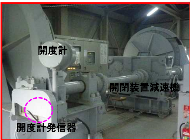
開閉装置の製作・据付
