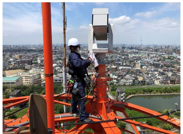
電気・通信設備の点検・整備
