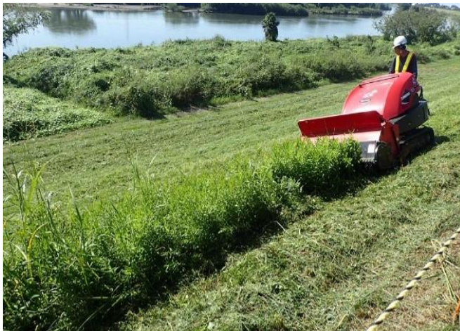
堤防除草 (堤防の異常を発見しやすくするため)
