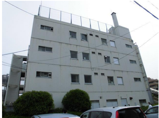
庁舎北側外観
