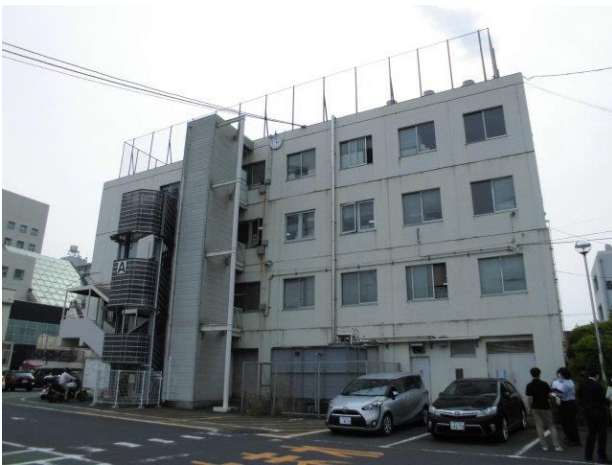
庁舎東側外観
