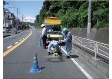
路面のポットホール（穴）の補修状況
