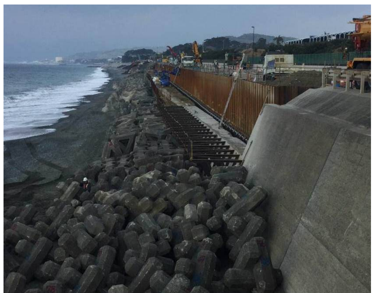
消波ブロック設置完了 (平成30年4月11日)
