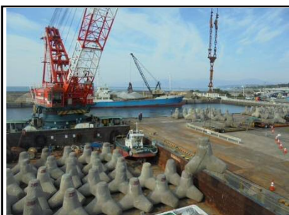
消波ブロックの荷下状況 (大磯港)
