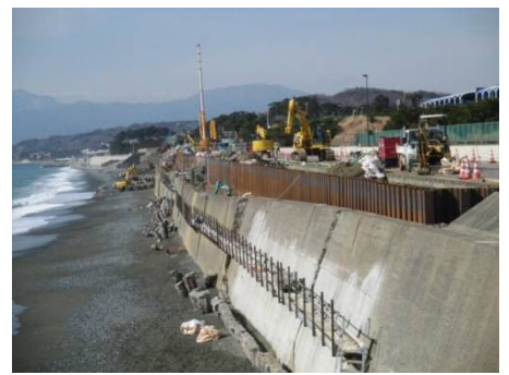
鋼矢板(2枚目)打設状況 (平成30年2月10日完了)
