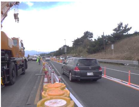
対面通行状況 (平成29年10月25日完了)
