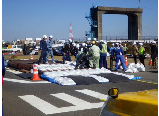
土のうによる段差解消
