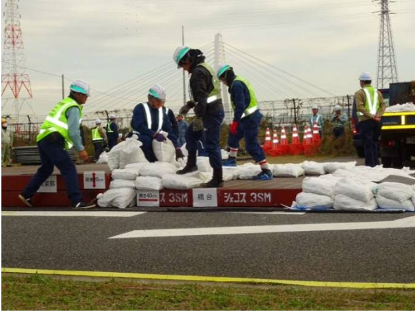
土のうによる段差解消
