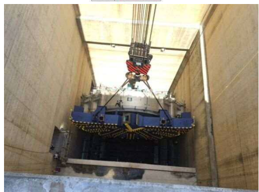
【横湘トンネル工事状況(平成29年4月撮影)】
