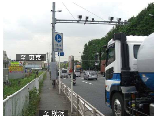
【歩道整備前の状況】 (川崎市幸区小向仲野町 下り線)
