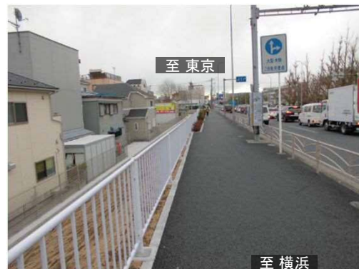
【歩道整備後の状況】 (川崎市幸区小向仲野町 下り線)
