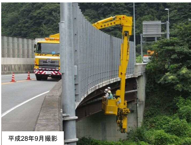
橋梁点検状況（遠景）
