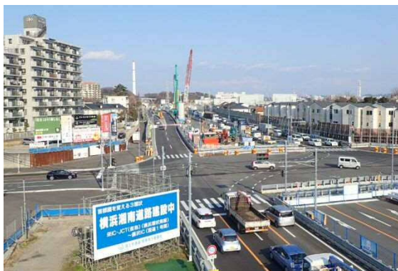
【藤沢立坑工事状況(平成29年3月撮影)】
