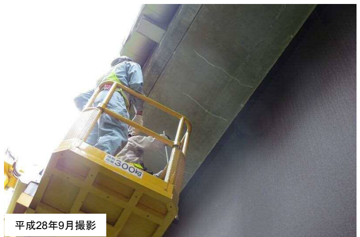
橋梁点検状況（近景）
