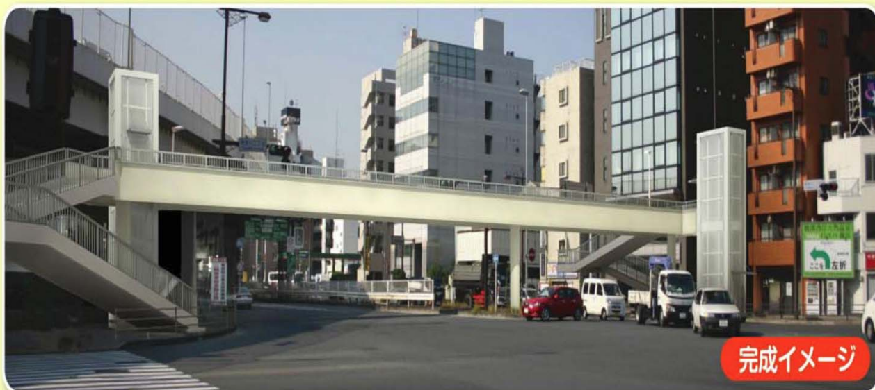
歩道橋架け替え後
