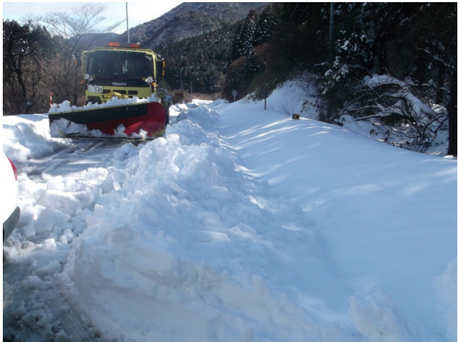
箱根新道での除雪作業
