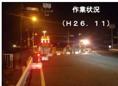
▲通行規制の状況
