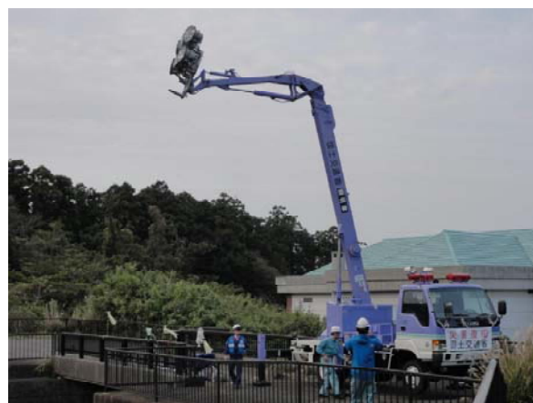
【大島災害派遣（H25.10東京都大島町）同型機】
