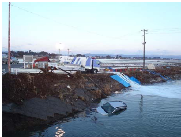
【東日本大震災（H23.3宮城県岩沼市）同型機】
