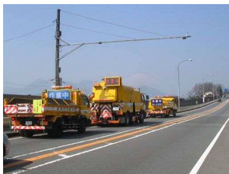
清 掃 (路面清掃・排水施設清掃等)
