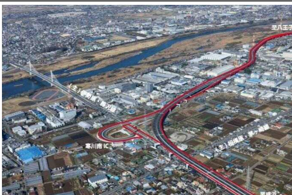
寒川南IC付近(平成26年1月撮影)
