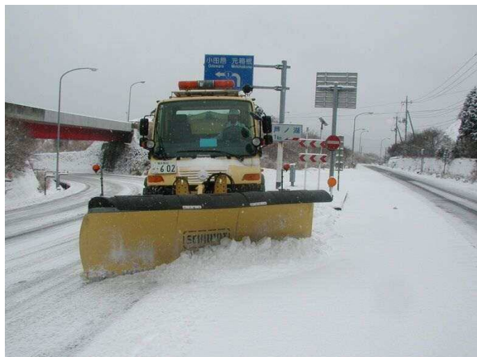
除雪作業 (国道1号箱根新道)
