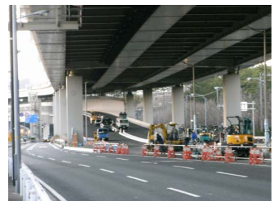
④アプローチ部（本牧側）
