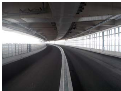
③高架橋部
