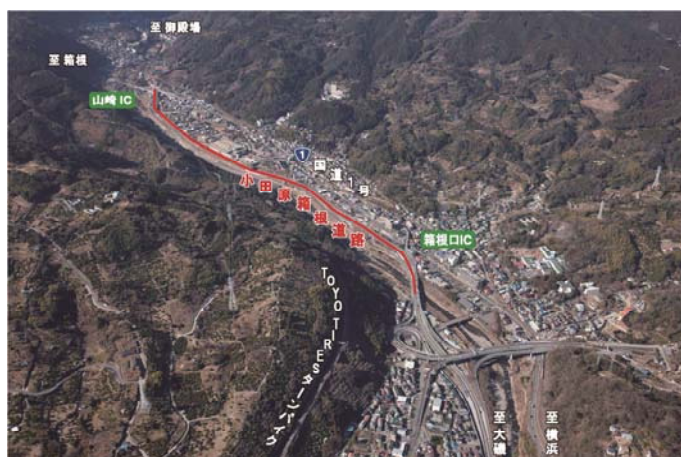
現在の状況 (平成25年1月撮影)
