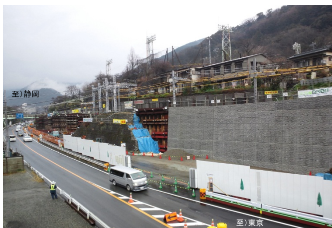
改良工事状況(箱根町湯本) (平成26年1月撮影)
