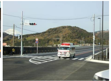
開通後のバイパスの様子 (平成24年12月21日9時頃撮影)
