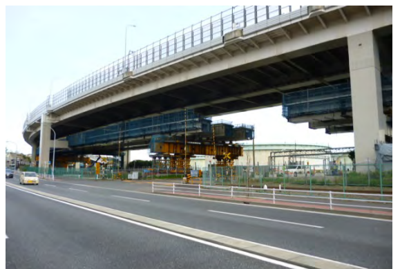
根岸地区の橋梁架設工事状況(平成24年4月撮影)
