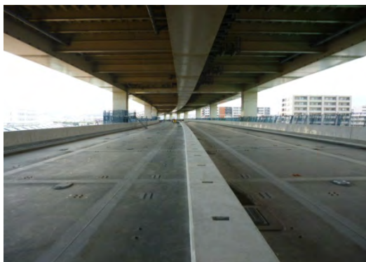
根岸地区の橋梁架設後の状況(平成24年4月撮影)
