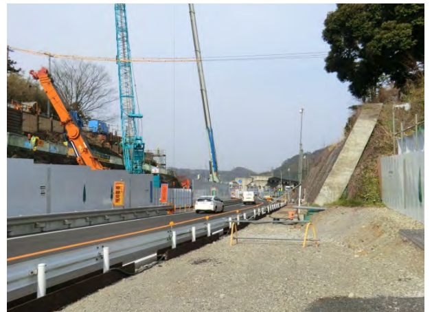
終点部の改良工事状況(箱根町湯本)(平成24年4月撮影)
