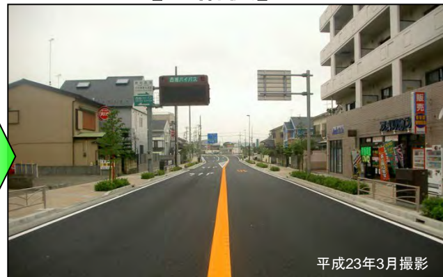
電線共同溝整備の事例 (国道1号 国府津電線共同溝)
