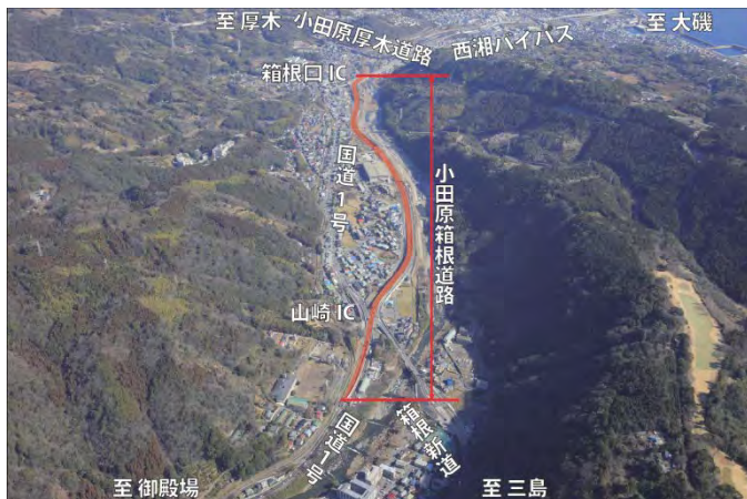
現在の状況(平成24年1月撮影)
