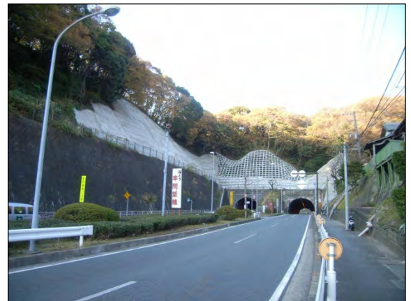
吹付法枠施工後
