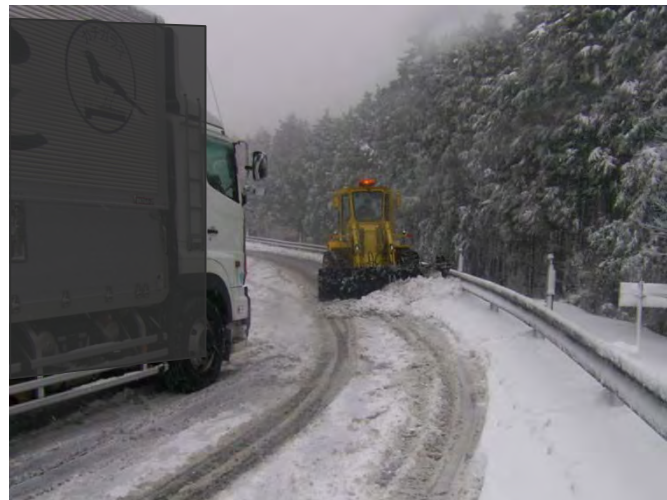
除雪作業 (国道1号箱根新道)
