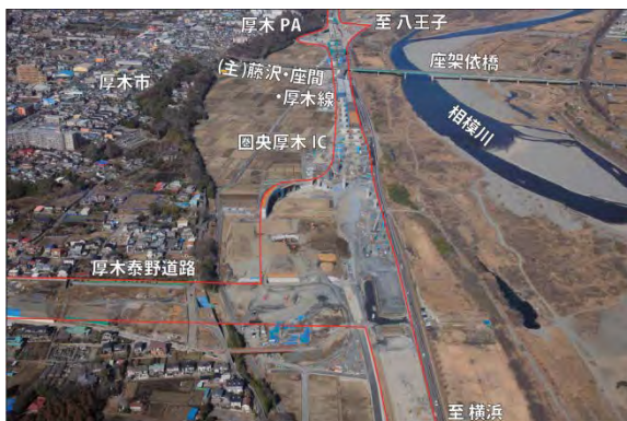
圏央厚木IC付近(平成24年1月撮影)
