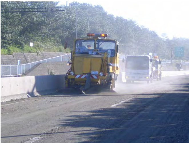
台風後の清掃作業 (国道1号西湘バイパス)
