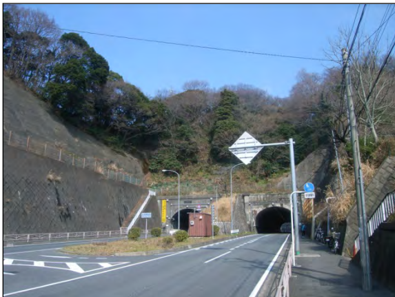
吹付法枠施工前
