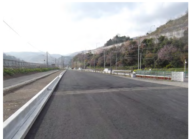
現道246号取付け部の状況(平成24年4月撮影)
