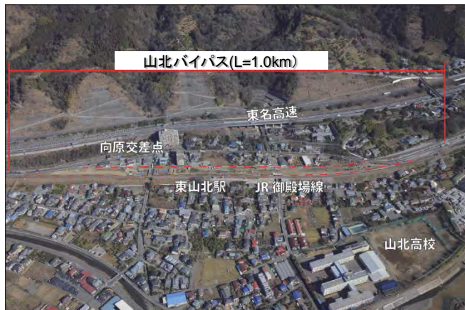
現在の状況(平成24年1月撮影)
