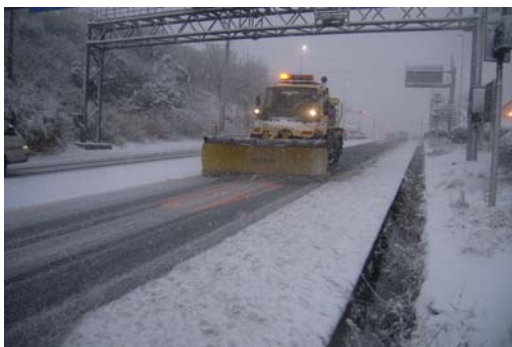
○箱根峠における除雪作業
