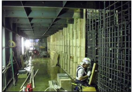
①下段の様子です。壁の工事(鉄筋と型枠の組立作業)を順次行っております。
