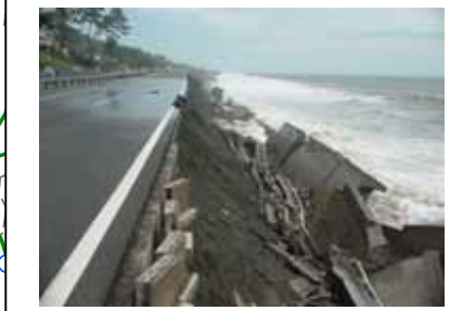
擁壁破損 路面崩壊
