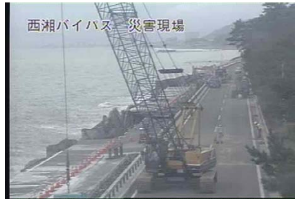
シートパイル施工のための クレーンを現地にて設置 (9日 15時00分撮影)
