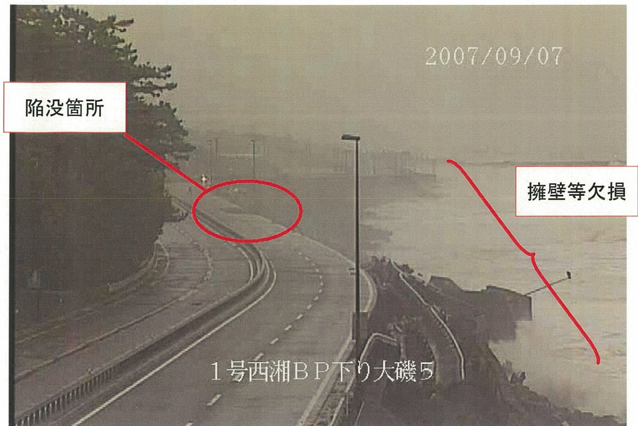
西湘バイパスにおける路面陥没、擁壁等欠損状況 (西湘二宮ICから大磯東IC方面を望む)
