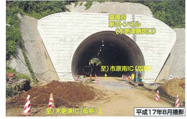
④ 真里谷第3トンネル(平成17年3月9日貫通)
