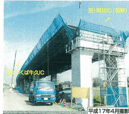
① 牛久高架橋(国道6号付近から常磐道方面を望む)
