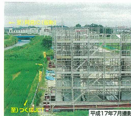
③ 牛久高架橋(つくばJCT方面から国道6号方面を望む)
