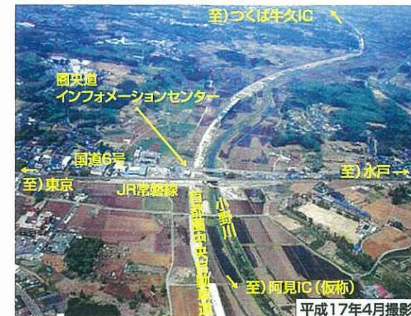
④ 国道6号交差部(つくば方面を望む)
