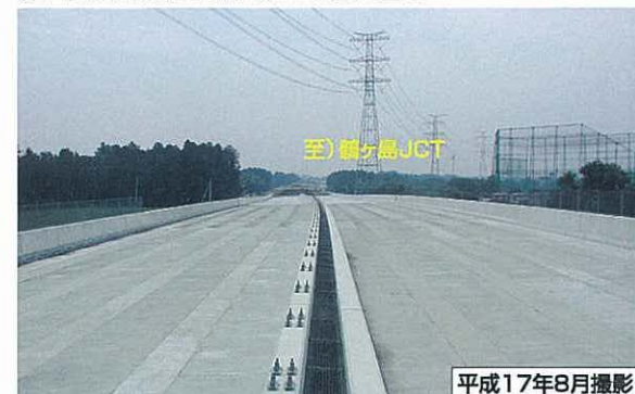
② 上広谷高架橋より鶴ヶ島JCT方向を望む
