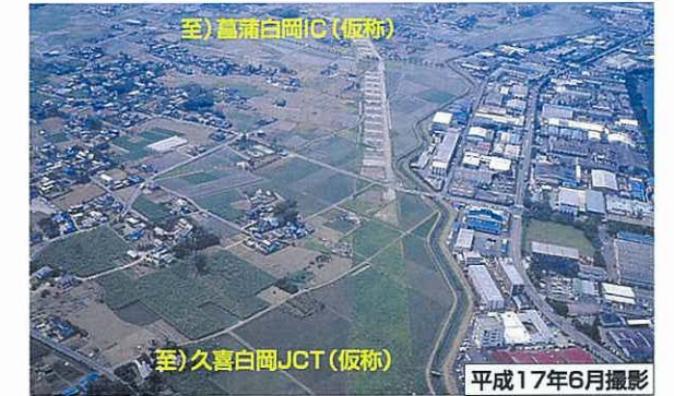
⑦ 葛蒲白岡IC(仮称)～久喜白岡JCT(仮称)間(葛蒲白岡IC(仮称)方向を望む)
