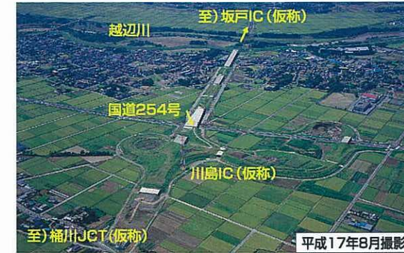
⑤ 川島IC(仮称)(坂戸市方面を望む)
