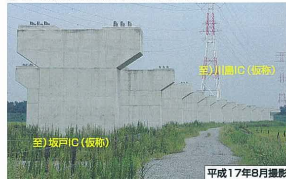
③ 坂戸高架橋より川島IC(仮称)方向を望む
