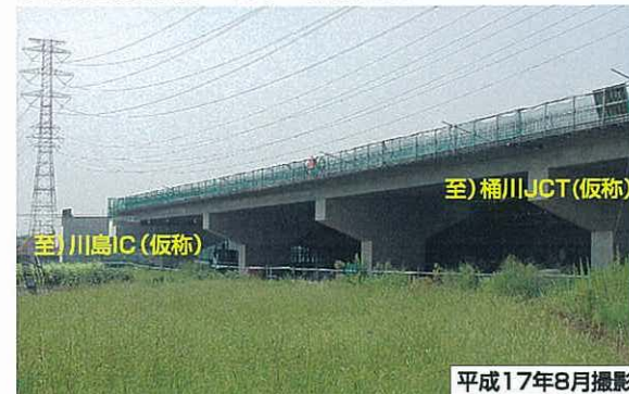
④ 川島連続高架橋より川島IC(仮称)方向を望む
