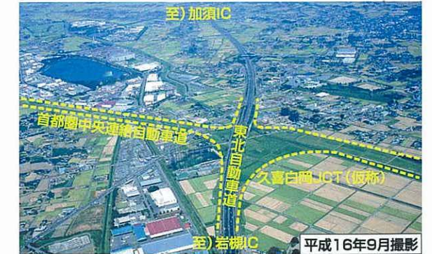
⑧ 久喜白岡JCT(仮称)(加須IC方面を望む)
