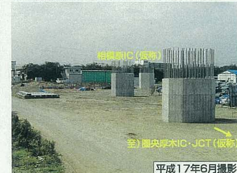
⑤ 相模原IC(仮称)より愛川町方面を望む(RC橋脚)
