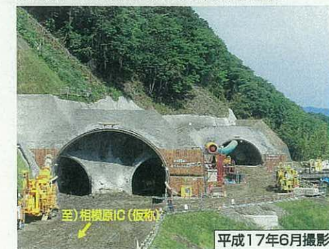
⑥ 愛川トンネル南坑口より城山町方面を望む
