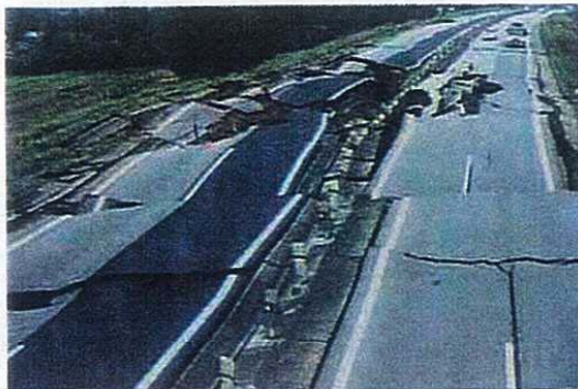
平成16年10月新潟中越地震 関越道の被災状況(堀之内IC~川口IC)
