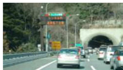
小仏トンネル坑口付近から八王子方面を撮影
