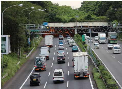
【①大和トンネル手前(上り線)】
