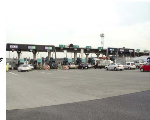
新座本線料金所 (関越自動車道)
