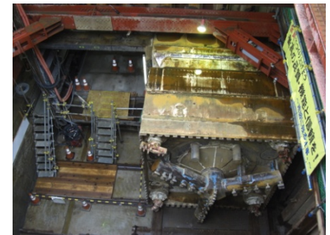
〔貫通したシールドマシン〕
