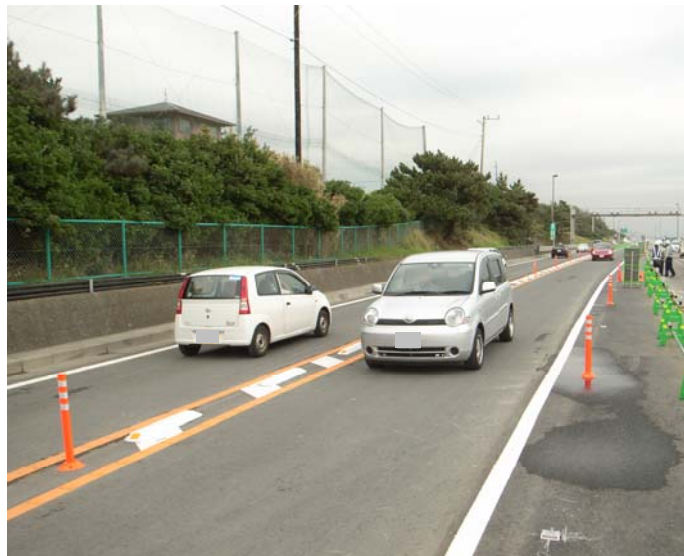
暫定2車線供用(平成19年9月27日)
