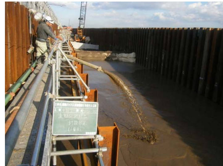
復旧工事状況(流動化処理土打設)(平成20年2月)
