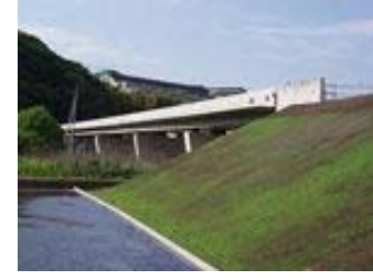
上依知高架橋 平成19年4月
