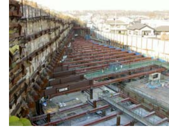
上依知第2トンネル(仮称) 平成20年1月
