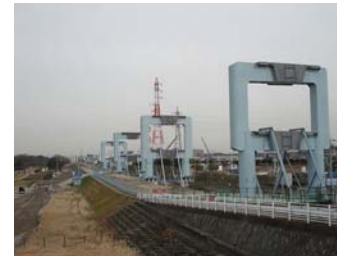
宮山高架橋 平成20年1月
