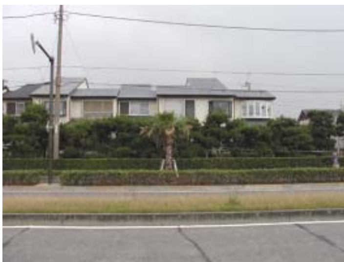
写真5.2 住宅側の防風用植栽と2階建て低層住宅
