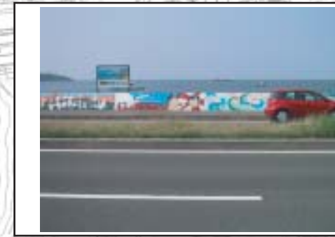
図5.2 対象区間の現況写真
