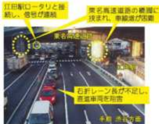
右折車による直進レーン阻害状況
