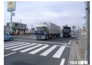
小山交差点付近の状況
